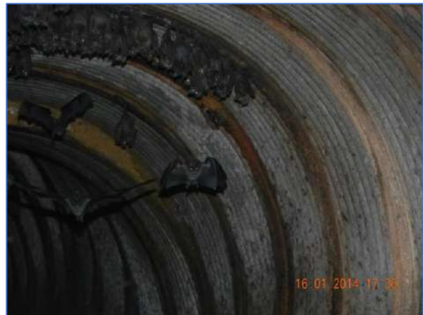
Murciélagos registrados en el interior de una alcantarilla. Shushufindi, Sucumbíos; enero 2014
